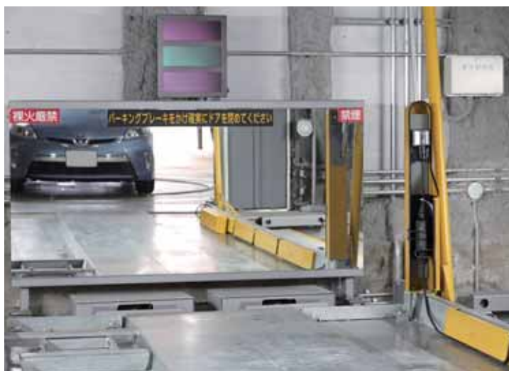
コンセントスタンド型の普通充電器は駐車パレットにコンパクトに設置され、使い勝手もよく、見た目もスマートだ。
