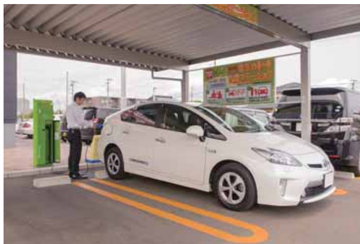
充電器は2つの充電ノズルを備え、同時に2台のEV・PHVへの充電が可能。店舗入口近くの目立つ場所に設置され、大きな表示で利用をアピールしている。
