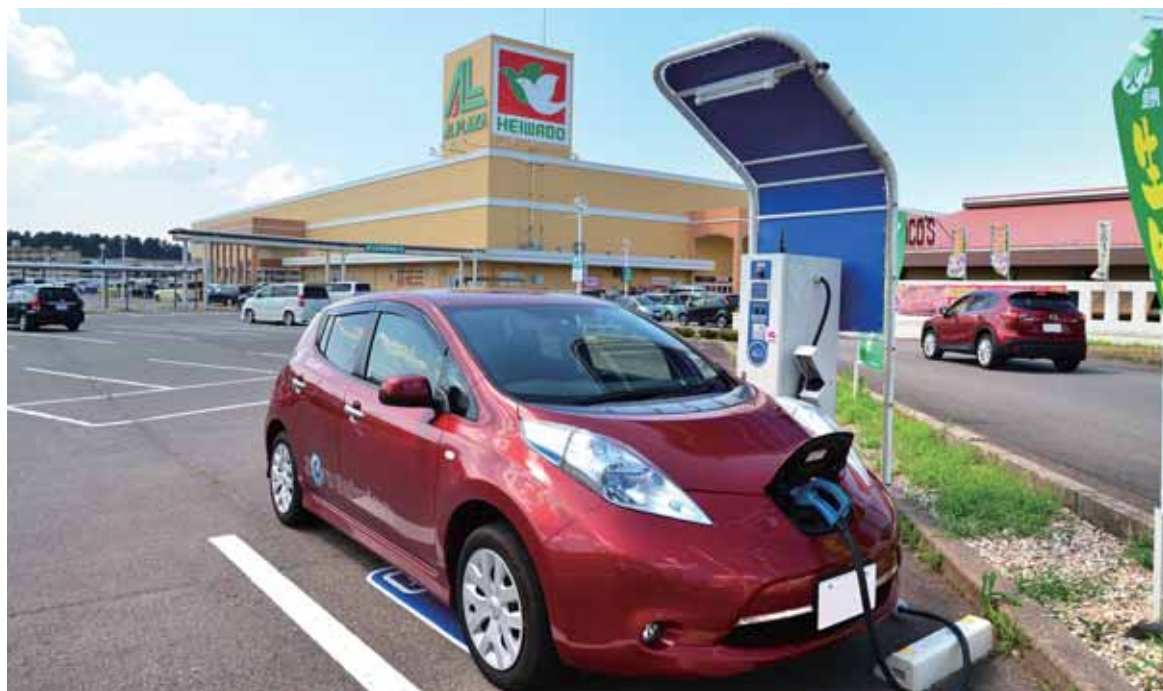
急速充電器が設置されている大型ショッピングセンター「アル・プラザ鯖江」(福井県)。国道8号線に面した駐車場に充電設備があるため、迷うことなく利用できる。顧客へのサービス向上とともに、買い物客の増加にも期待がかかる。
